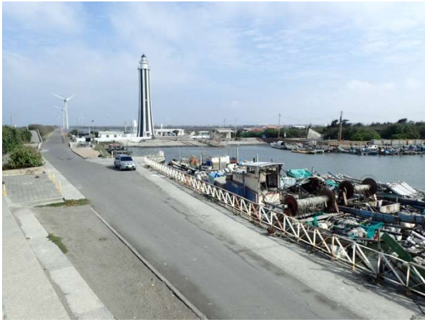
計畫範圍內的燈塔及船隻停泊區現況
