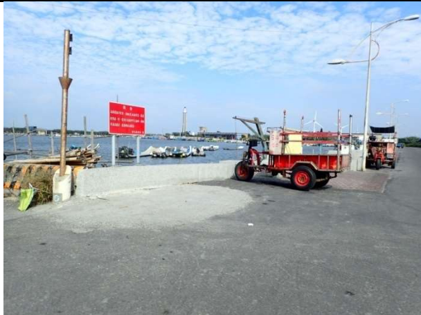
計畫範圍內之漁船停泊區現況
