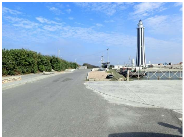
計畫範圍內的燈塔及道路設施現況
